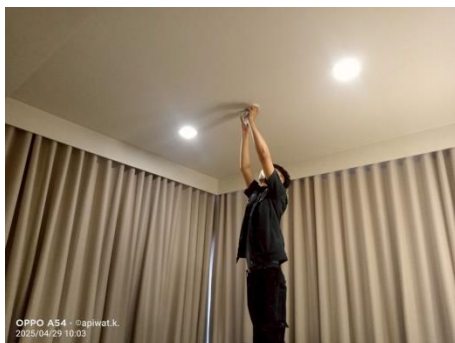
เจ้าหน้าที่ตรวจเช็คอุปกรณ์ตรวจจับควัน (Smoke Detector)
