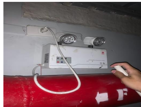
เจ้าหน้าที่ตรวจเช็คไฟส่องสว่างฉุกเฉิน
